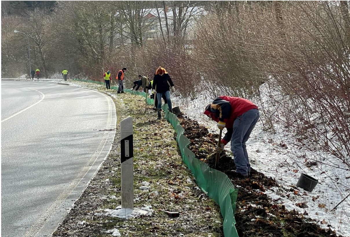
Abb.1: Blick auf die B88 vor dem Ortsausgang nach Seebach und auf den 500 m langen zu errichtenden Krötenschutzzaun
