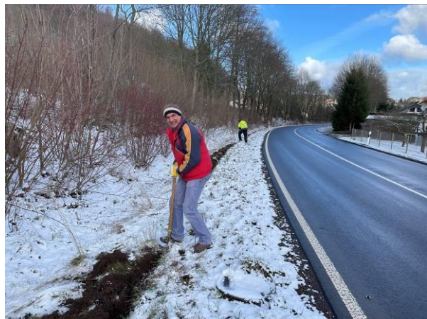
Abb.:3 Uwe Lindner beim Graben ausheben
