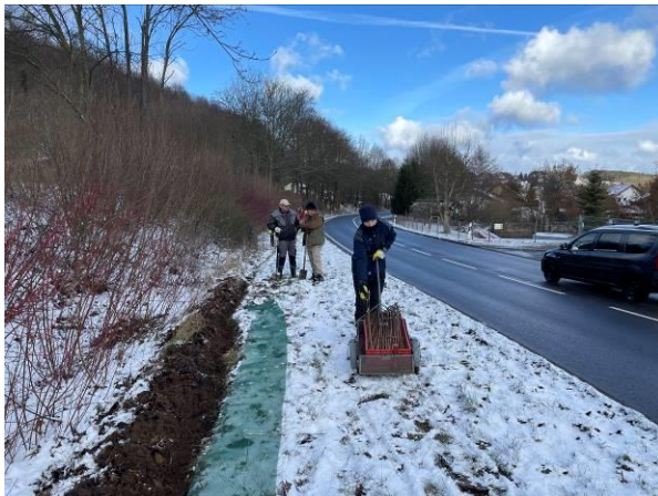
Abb.:6 Peter Földner beim Materialtransport
